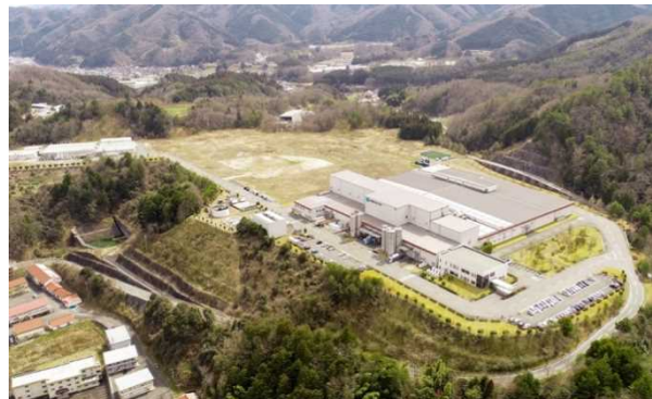
タキロンシーアイ 岡山工場
