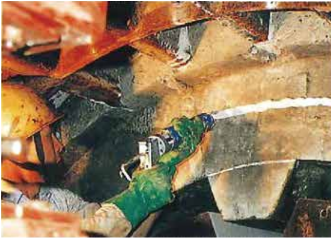
コンクリートの打ち継ぎ
