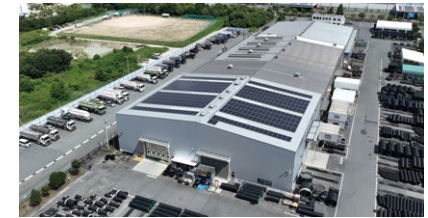
タキロンシーアイシビル(株)赤穂工場設置の太陽光パネル
